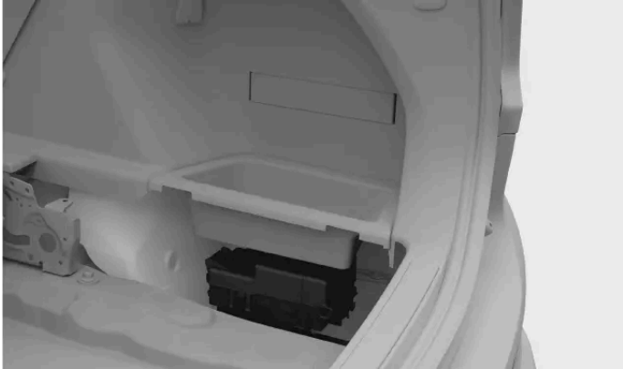
Ubicación de la caja de fusibles
