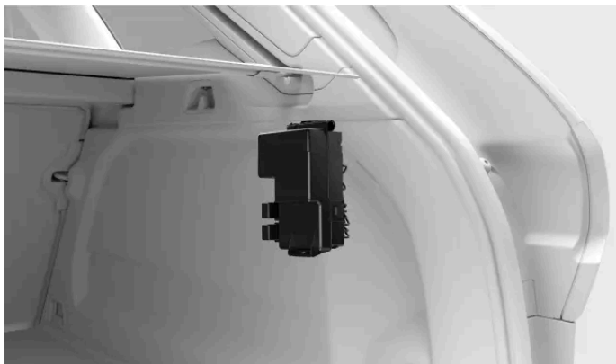
Ubicación de la caja de fusibles
