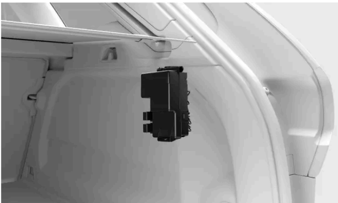
Ubicación de la caja de fusibles
