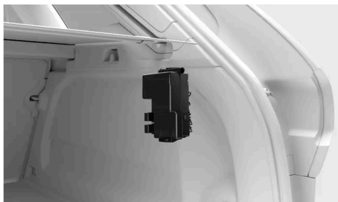
Ubicación de la caja de fusibles
