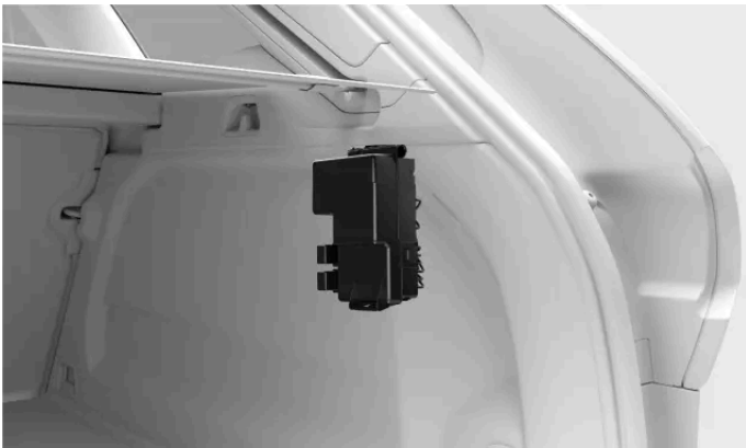
Emplacement de la boîte à fusibles
