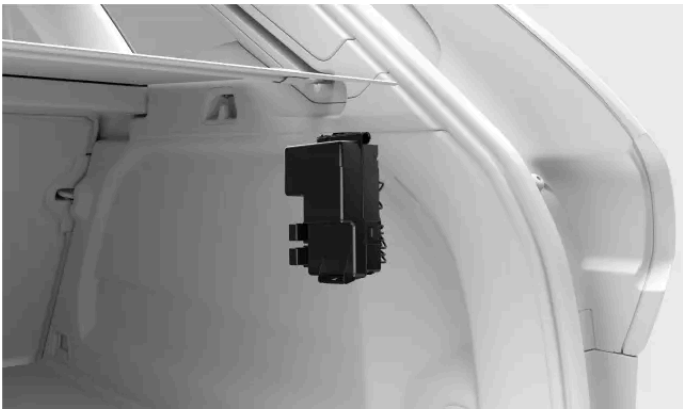
Emplacement de la boîte à fusibles
