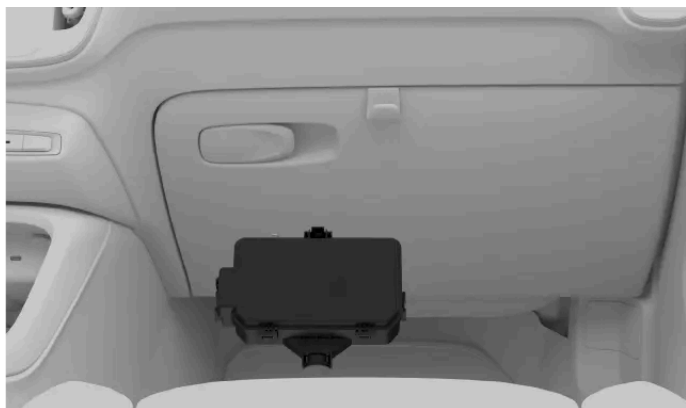
Localização da caixa de fusíveis
