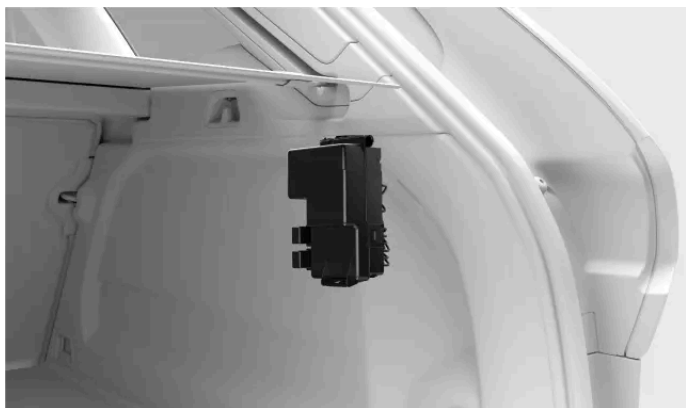
Localização da caixa de fusíveis
