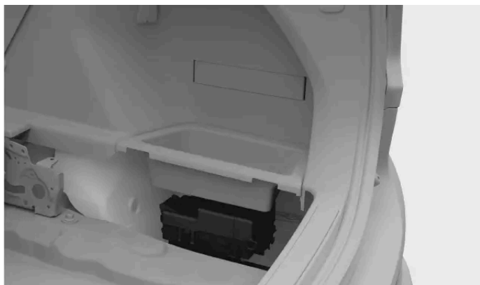
Emplacement du boîtier à fusibles
