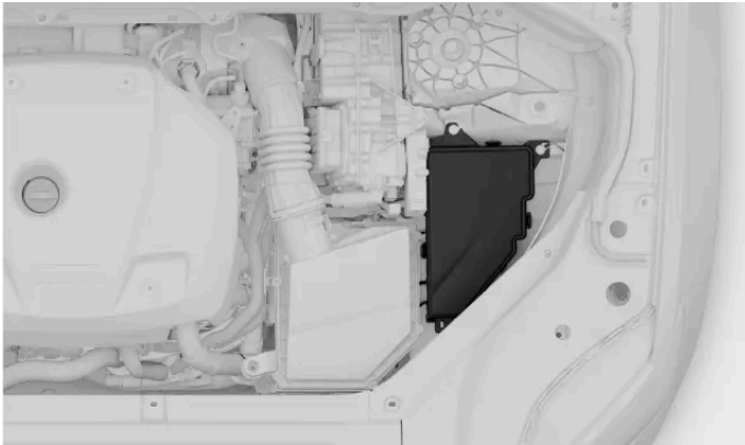
Lage des Sicherungskastens
