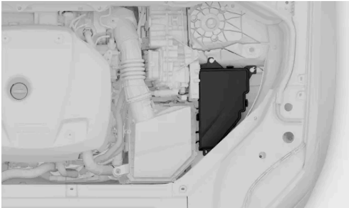
Lage des Sicherungskastens
