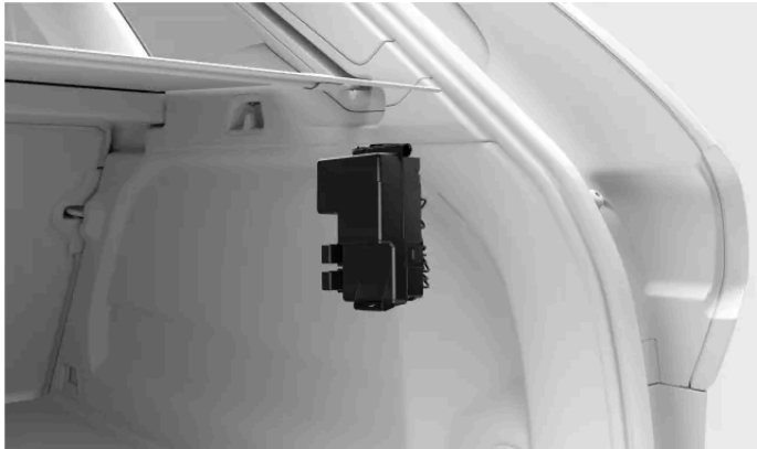
Lage des Sicherungskastens
