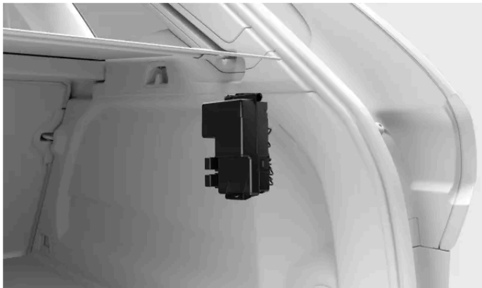
Lage des Sicherungskastens
