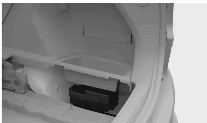
Placering af sikringsskab
