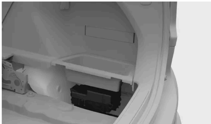
Placering af sikringsskab
