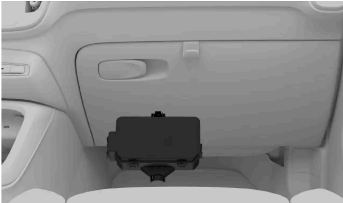
Placering af sikringskab
