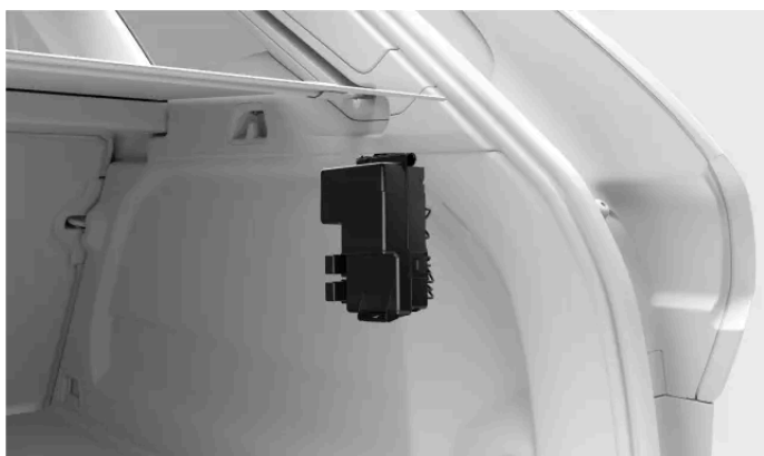
Placering af sikringsskab
