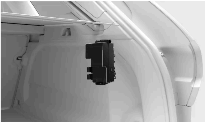
Placering af sikringsskab
