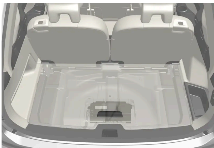
Biler af typen mildhybrid har et 48 V-støttebatteri placeret under lastrummet. Batteriet og boksen omkring det må kun håndteres af et autoriseret værksted.
