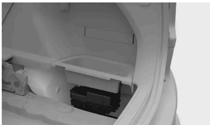
Placering af sikringsskab
