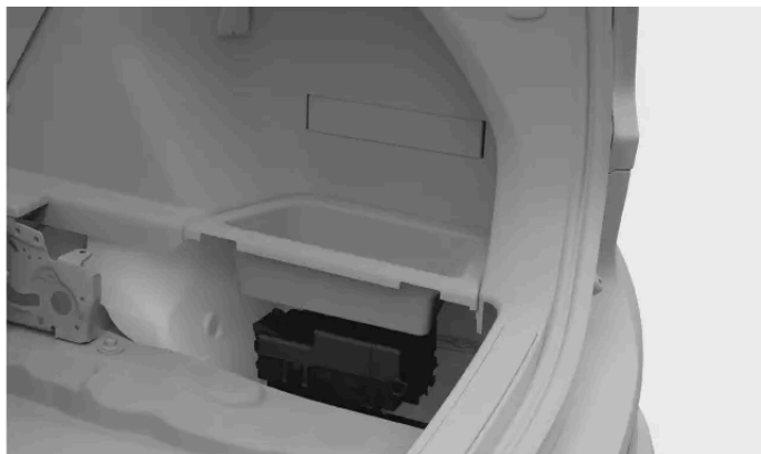
Placering af sikringsskab
