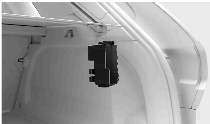
Ubicación de la caja de fusibles
