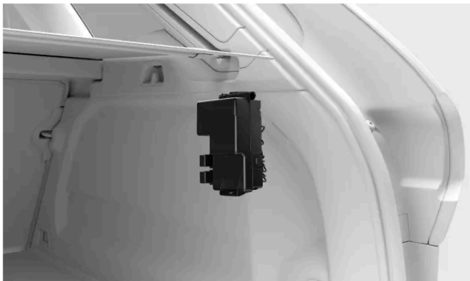
Ubicación de la caja de fusibles
