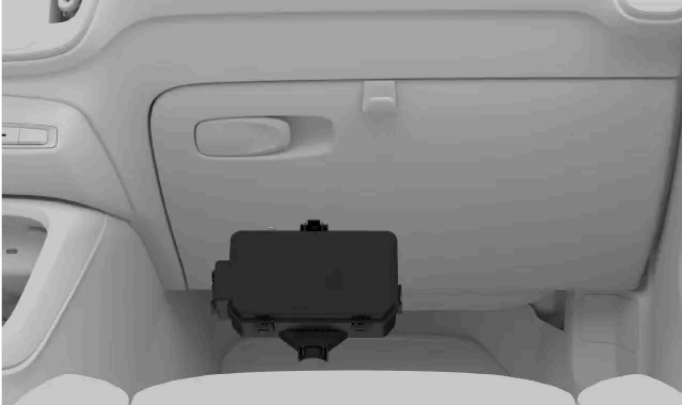
Emplacement de la boîte à fusibles
