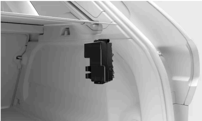
Emplacement de la boîte à fusibles
