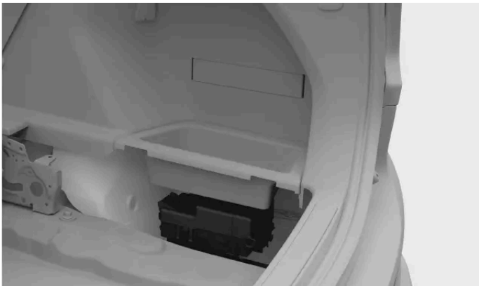
Emplacement de la boîte à fusibles
