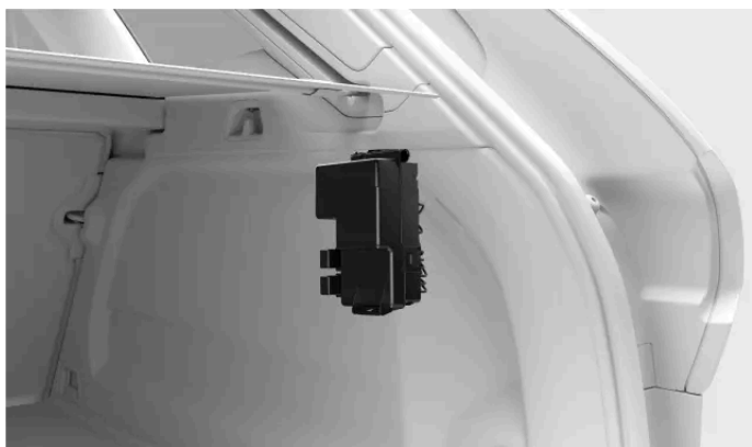
Emplacement de la boîte à fusibles
