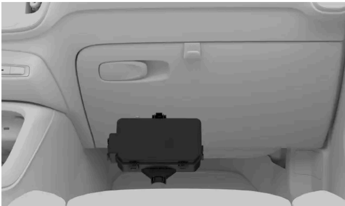
Plassering av sikringsskap
