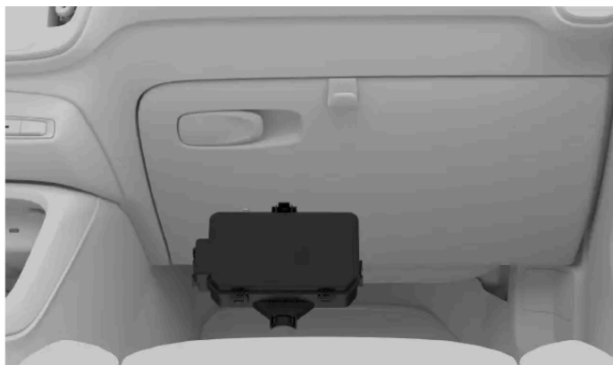
Położenie skrzynki bezpieczników
