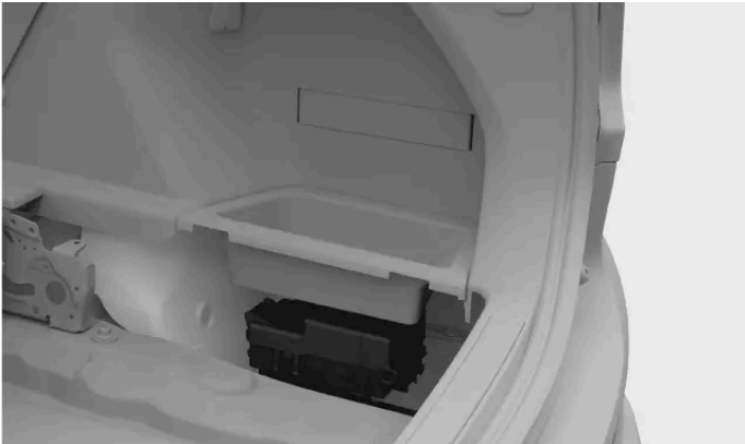
Położenie skrzynki bezpieczników
