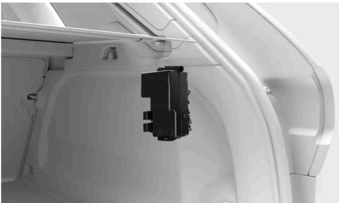
Położenie skrzynki bezpieczników
