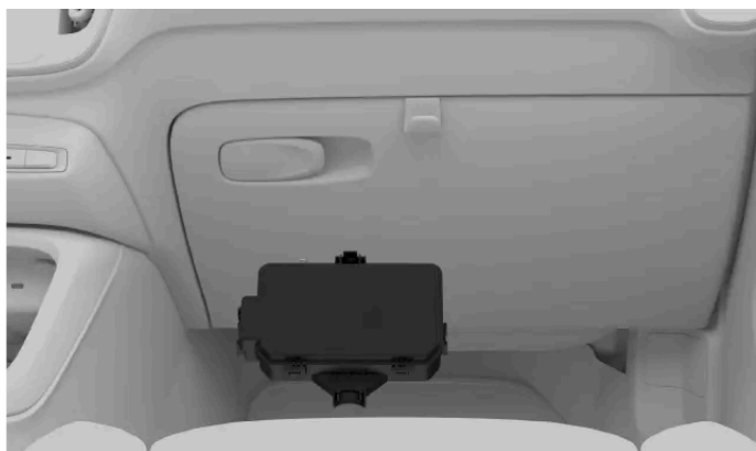
Localização da caixa de fusíveis
