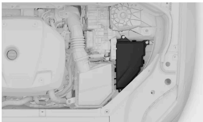
Localização da caixa de fusíveis
