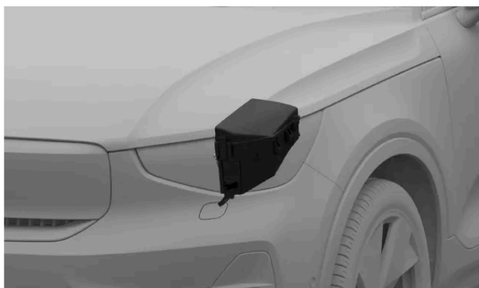
Ubicación de la caja de fusibles
